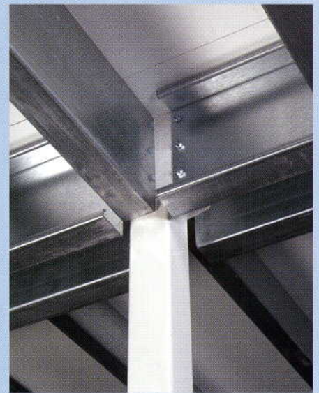
Verbindung Stütze/Träger
